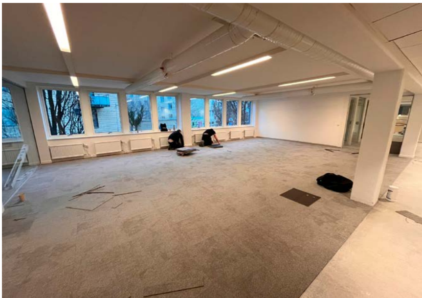
I det nya kontoret får driftspersonalen ett eget arbetsrum.
