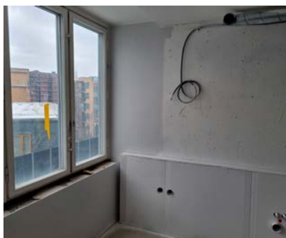
Här blir det ett kök så småningom.
