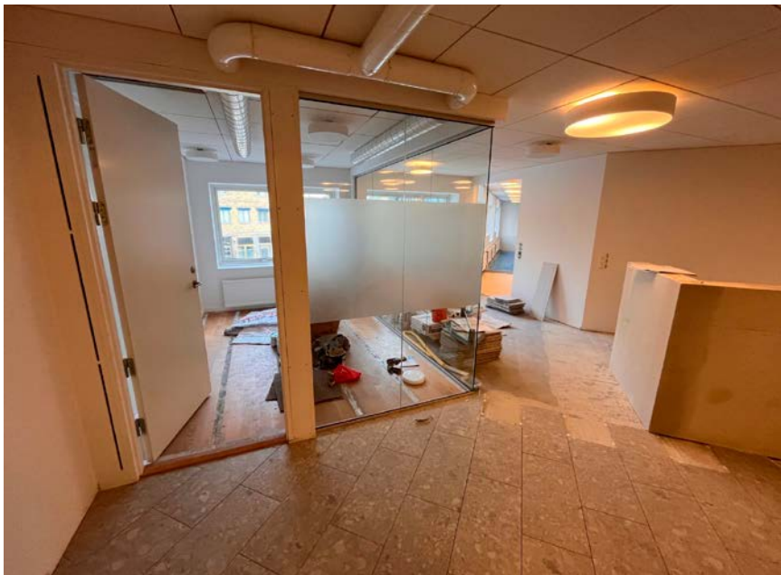
Receptionen med ett eget kontor för Cecilia Macina. Ombyggnaden ska förhoppningsvis vara klar nu.
