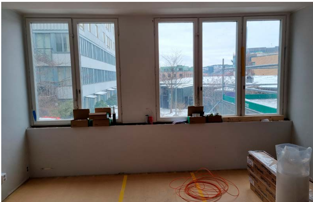
Utsikt från ett blivande vardagsrum.
