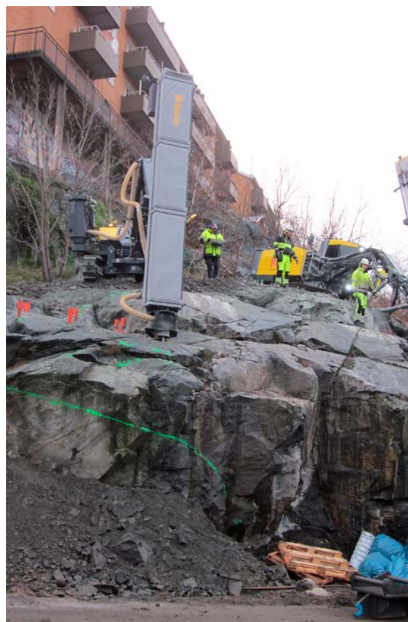
Sprängningen påbörjad och djupa hål borras för nästa sprängning.
