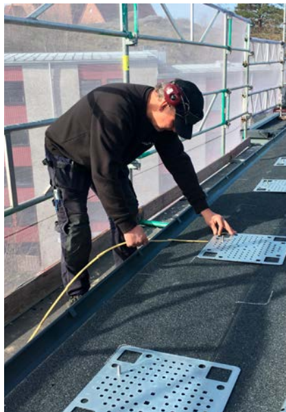
Torgny Svenlind mäter plåtar som ska monteras.
