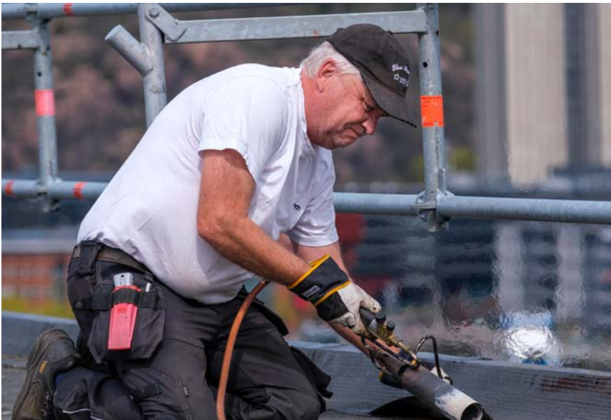
Takreningen som påbörjades våren 2023 är nu avslutad. Anders Söderlund är en av dem som gjorde jobbet. Foto: Håkan Linger.
