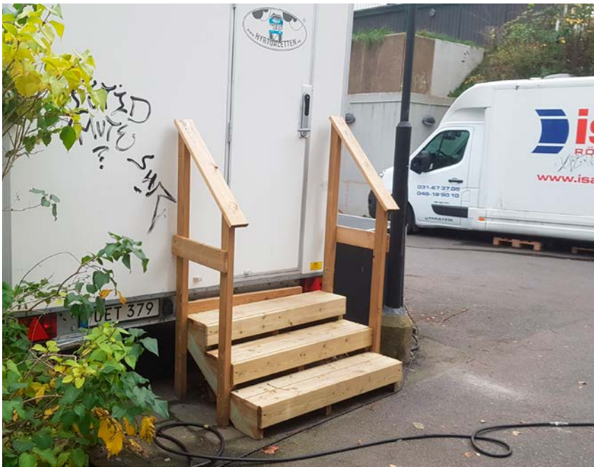
Den lite trånga trappan till containern med toaletter byttes ut mot en ny med väl tilltagna trappsteg .
