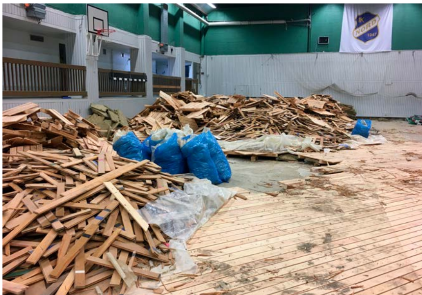
Parkettgolvet och undergolvet i trä körs ut med skottkärror medan plast och isolering läggs i olika plastpåsar.
