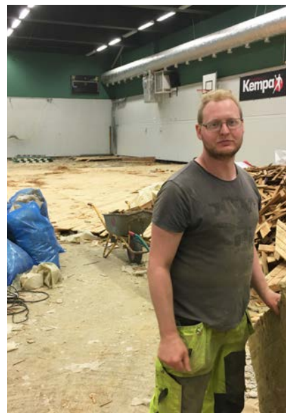
David Gustafsson, på CS Riv & Håltagning, leder rivningsarbetet av golvet i Masthuggshallen.
