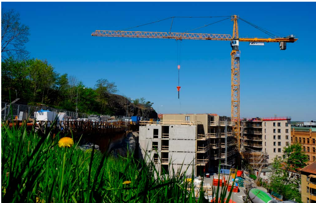
Stomresning av husen längs med Kjellmansgatan pågick i maj. Inflyttning är beräknad till april 2024.
