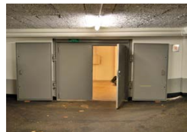
Ingången till skyddsrummet i garaget på Kjellmansgatan 28.
