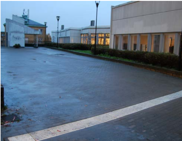
Brf Masthugget har i samråd med SRF Göteborg ordnat ledstråk på Masthuggsterrassen så att det är lättare att ta sig till lokalen från hissen.
