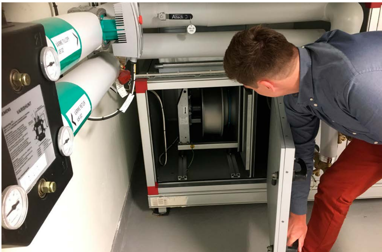
I aggregaten finns en elektroniskt styrd fläkt som anpassar luftflödet efter behovet.
