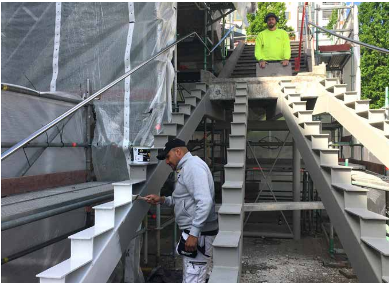
Erick Negrete från Edvardsson Måleri AB målar trappfundamenten. Träplanstegen är borttagna för rengöring. I bakgrunden står arbetsledaren på Väst kustens Mur & Kakel, Johnny Svensson.
