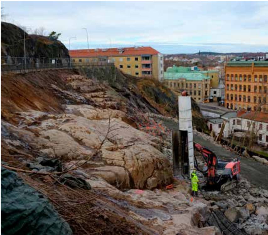
Stora delar av berget måste bort innan det är dags att bygga.
