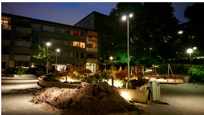
Rabatten uppgrävd för elarbeten, september 2020. Foto: Aina Gürlet.
