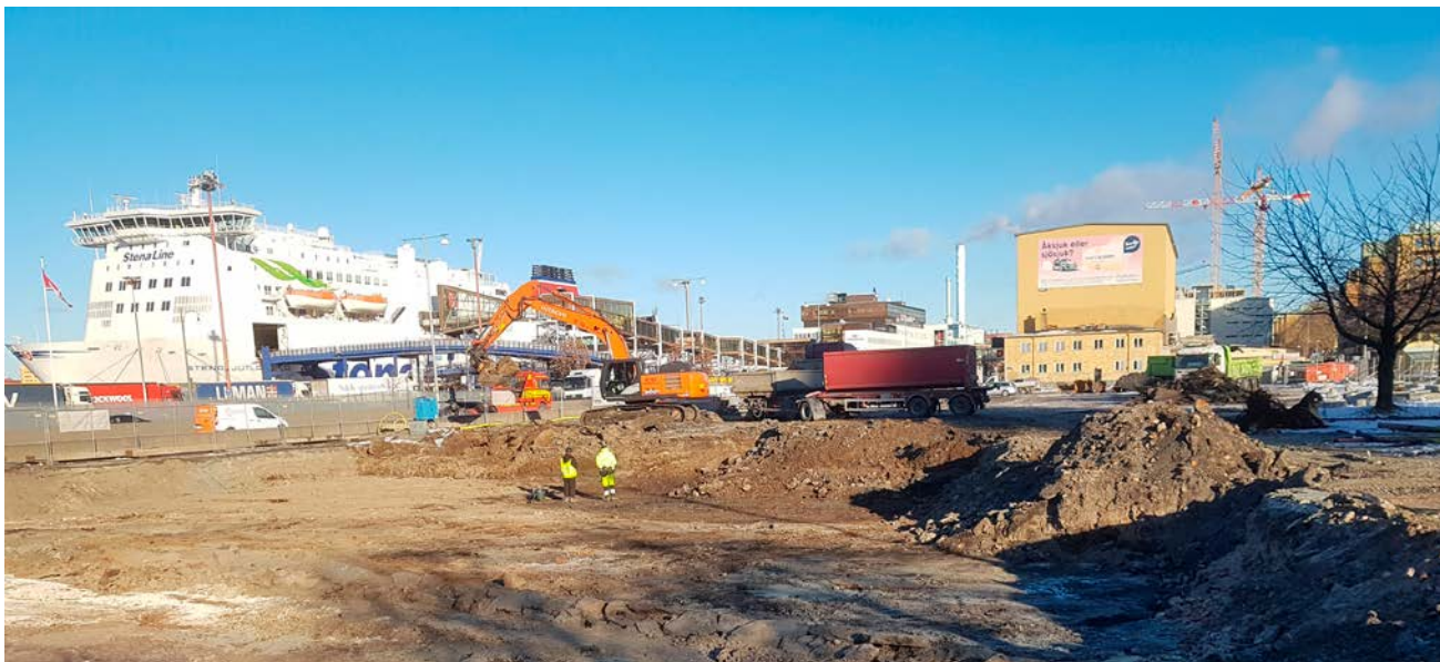
Gropen där det blivande p-huset ska ta form.
