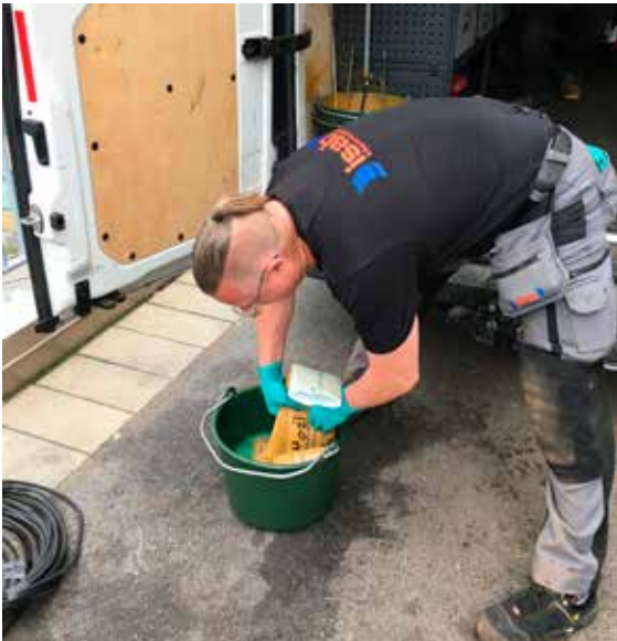
Anders Hallgren doppar strumpan i såpvattnet så att den ska glida bättre i röret när den skjuts in i avloppsröret och vrängs ut och in.
