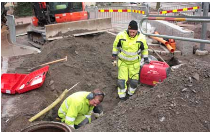
Christan Lindgren och Hans Feldt, lägger en dagvattenledning från den nysatta brunnen. Tidigare var det en lågpunkt där vatten blev stående.
