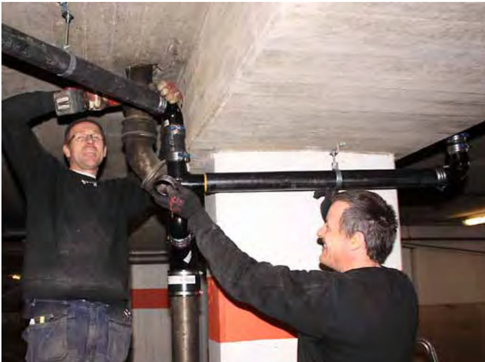
Håkan Börjesson och Bo Börjesson byter ut gamla plaströr mot nya, rejäla i gjutjärn.
