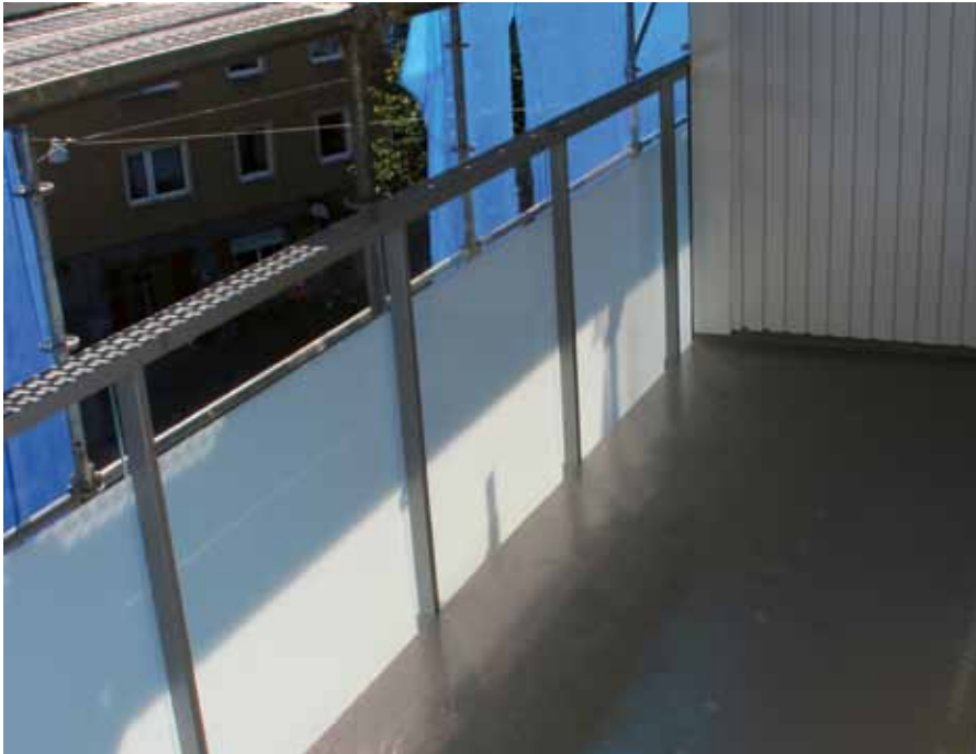
Balkongerna får ett rejält lyft. Balkongplattorna lagas och förstärks, panel som skadats byts ut och nya fronter och räcken monteraras. Alla balkonger får också nya eluttag. Foto: Daniel Lindgren
