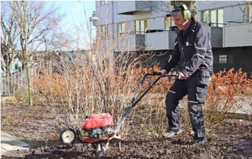
Gert återställer marken vid Fjällgatan efter dragningen av de nya fjärrvärmeledningarna.
