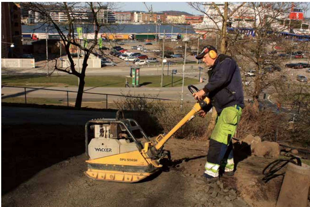
Patrik Niklasson, från PVN Mark & Schakt AB, breddar den branta uppfarten vid Johanneskyrkan till Masthuggsterrassen för byggtrafiken och räddningstjänsten.
