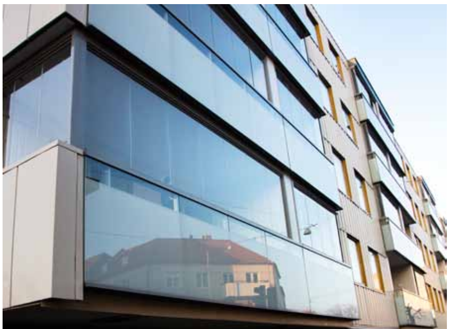
De första husen har nu fått sina fasader renoverade. Dessa balkonger vätter mot Fjällgatan. Foto: Thomas Johansson
