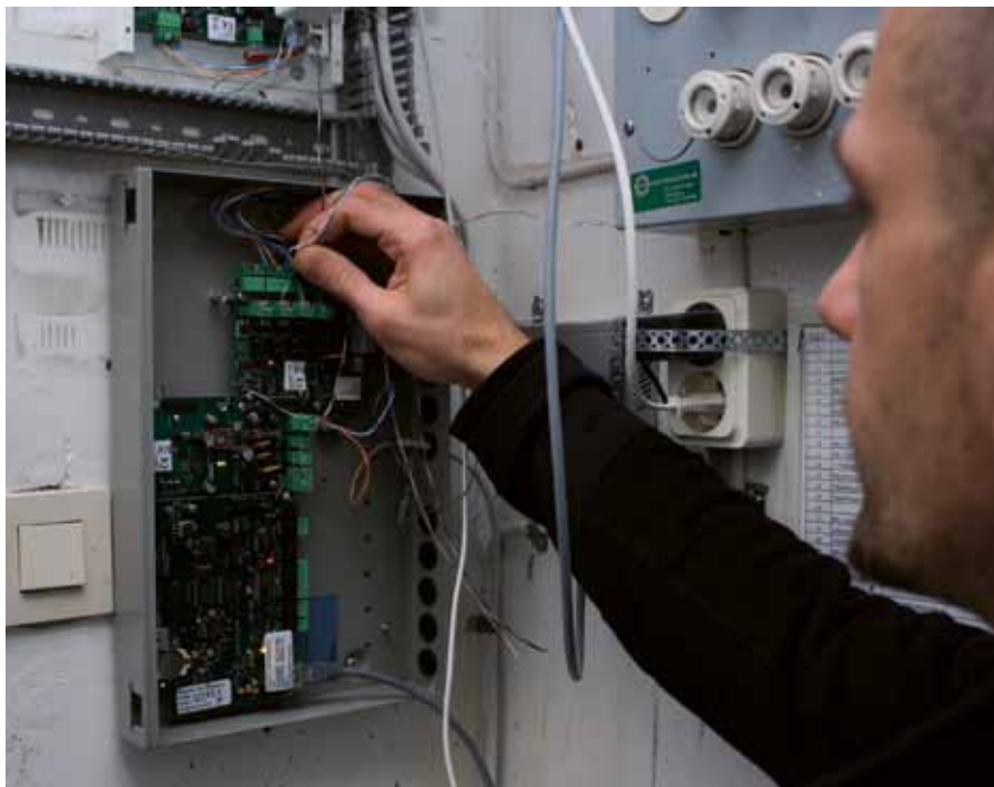
Nokastechnikern Vedad Dulic installerar en av alla små centraler till de nya porttelefonerna.
