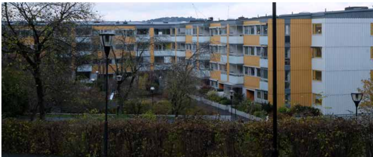
Mattssonsliden är en av de adresser vars hus ligger först på tur för rörrenoveringen.
