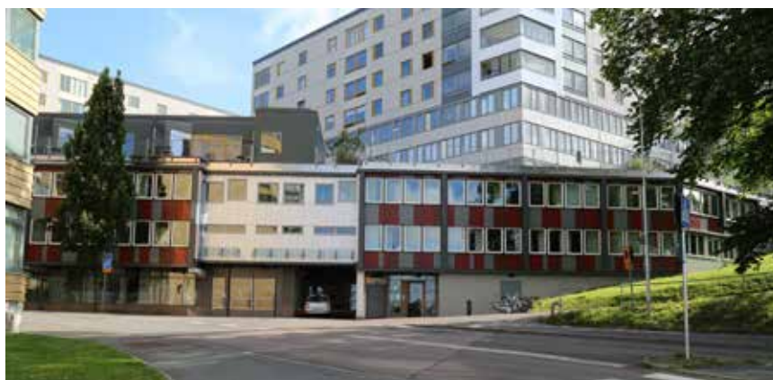
Den nya fasaden innebär ett lyft både utseendemässigt och för inomhusmiljön.
