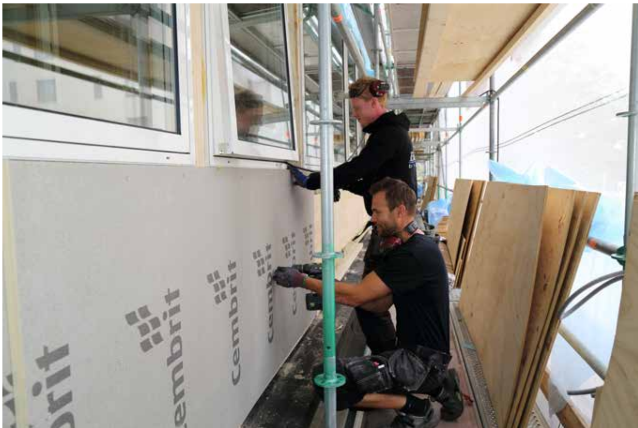
Marcus Edgren och Philip Hegmo monterar ny fasadskiva innan den nya fasadplåten slutligen kommer på plats.
