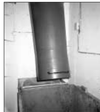
Provinstallation av förvaltningens alternativa sorteringsanläggning i soprummet till Mattssonsliden 8–10.
