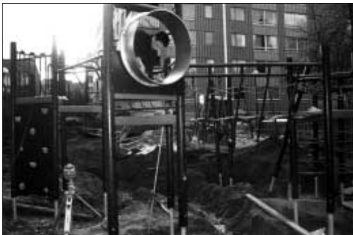
Tomas Rosenö från TMM i full färd med ombyggnaden
