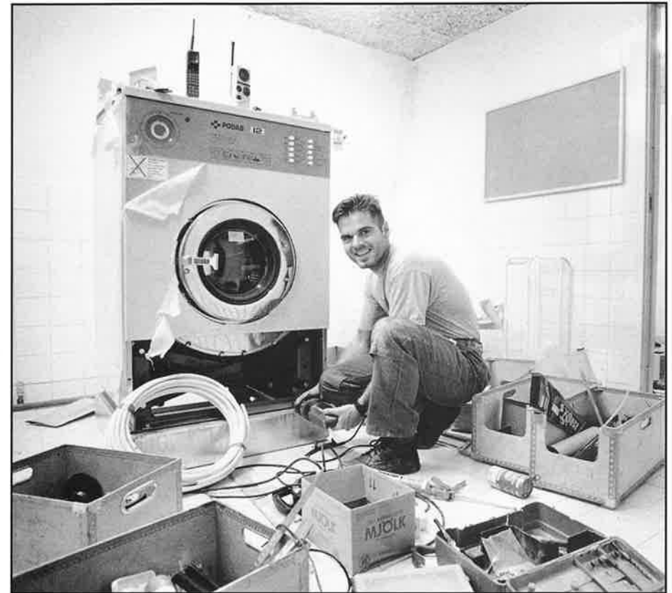
Ulf Thorsén från BPA EL installerar den nya tvättmaskinen för mattor och annan omfattande tvätt. Foto: Anders Ocklind.
