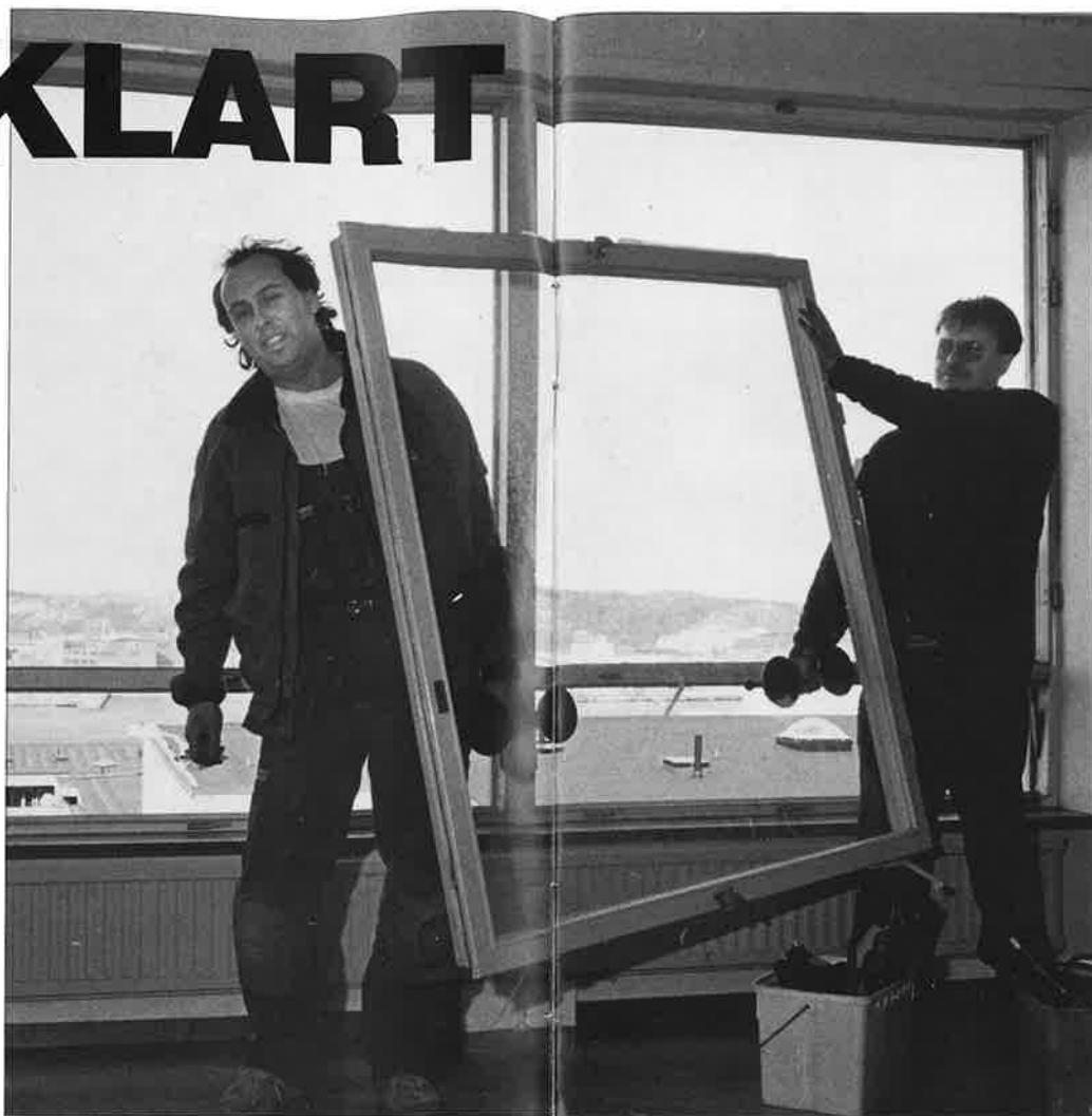
Mats Snygg och Christer Uhlin med ett av de 4 500 fönster de ska byta ytterbågar på. Ett tungt jobb eftersom alla fönster måste baxas ner i källaren och upp igen. Foto: ANDERS OCKLIND
