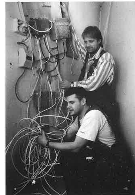
HÅKAN GÖRASS OCH BOBO SÖDERÉN FRÅN AT INSTALLATION
